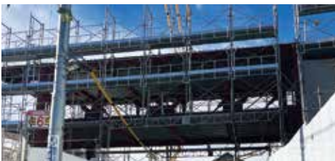
鷺宮小西中野小統合新校の工事現場
